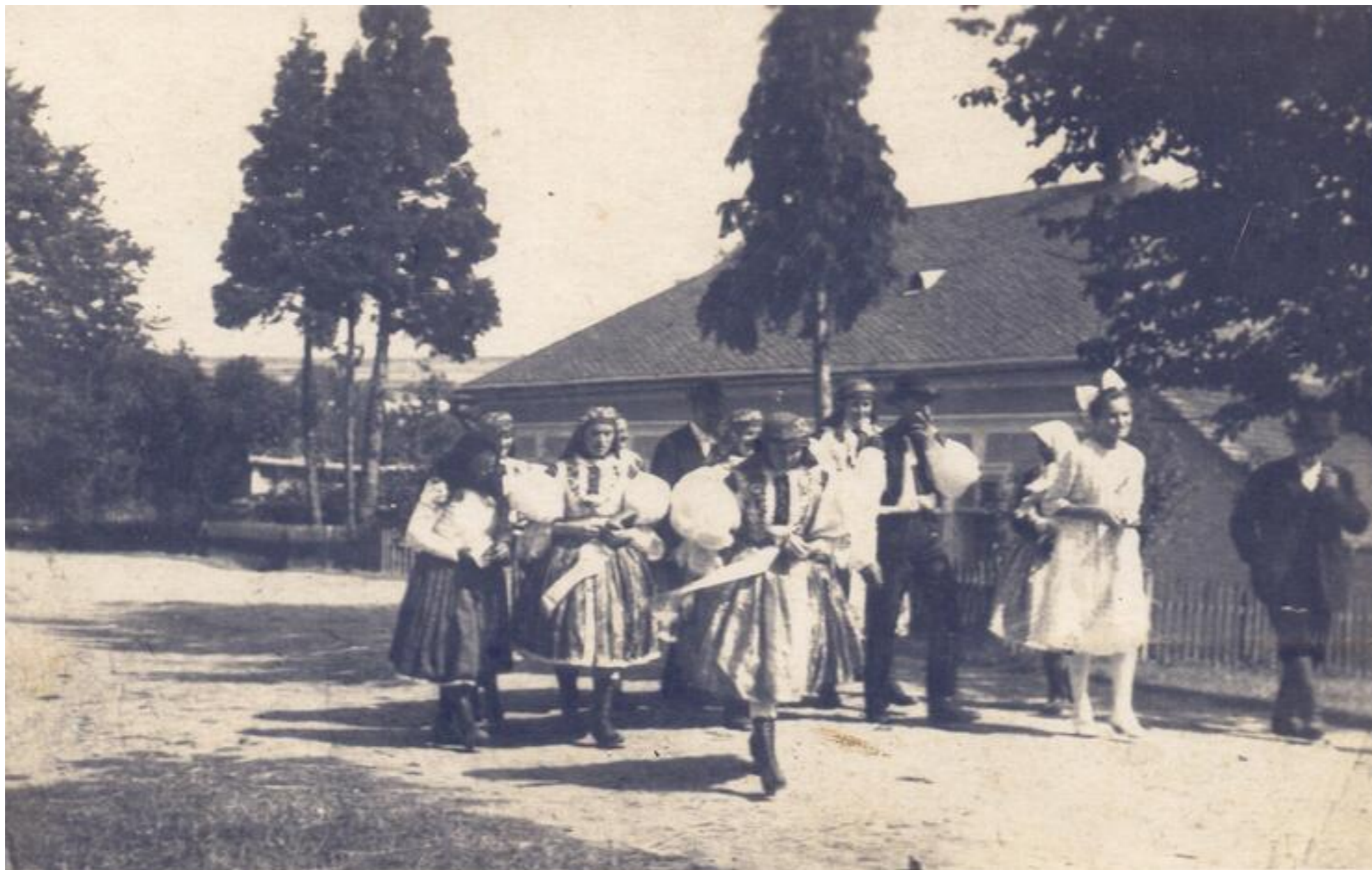
foto: Původní jednopodlažní budova fary
