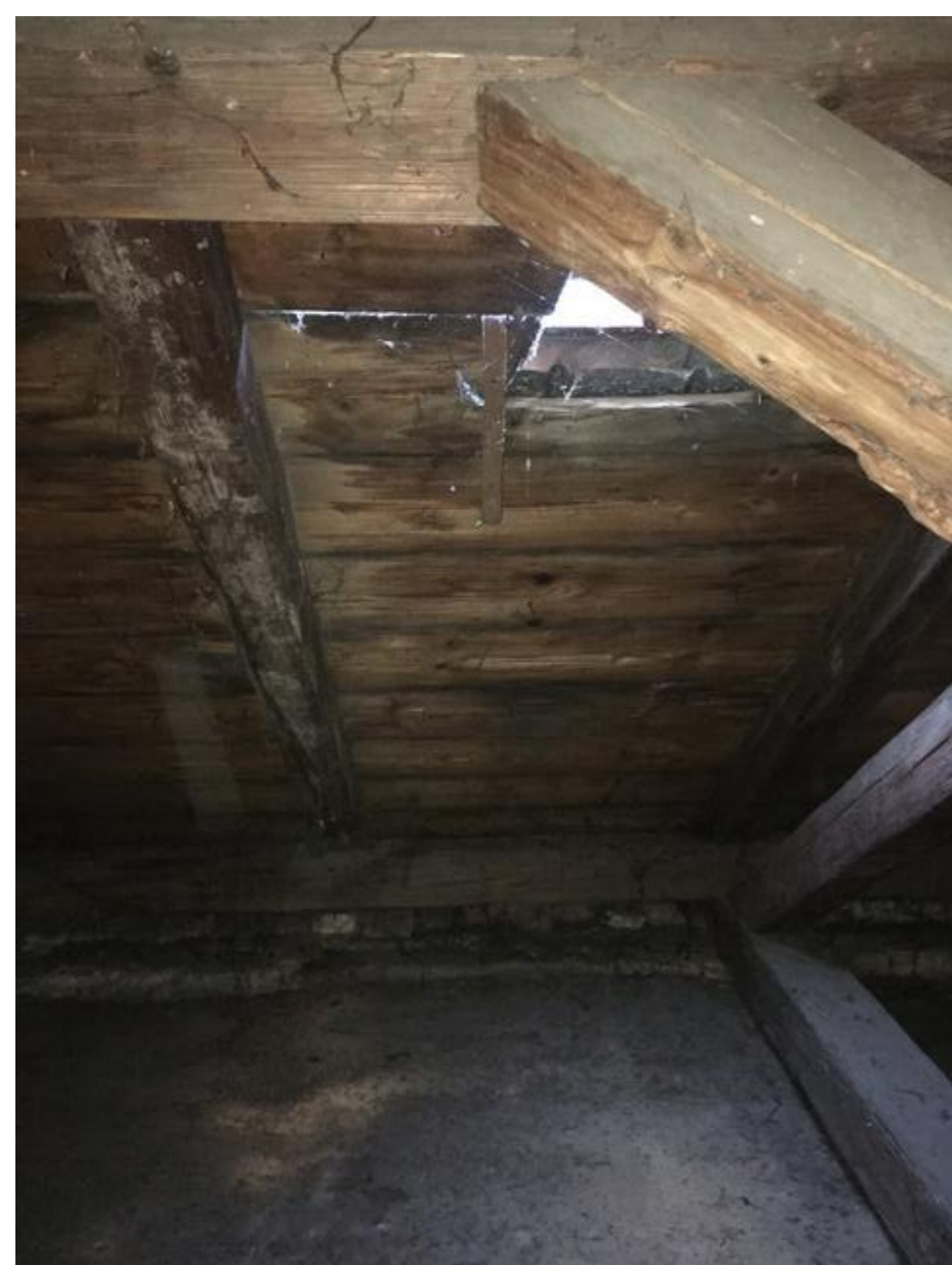
Místy trámy krovu napadeny dřevokazným hmyzem
