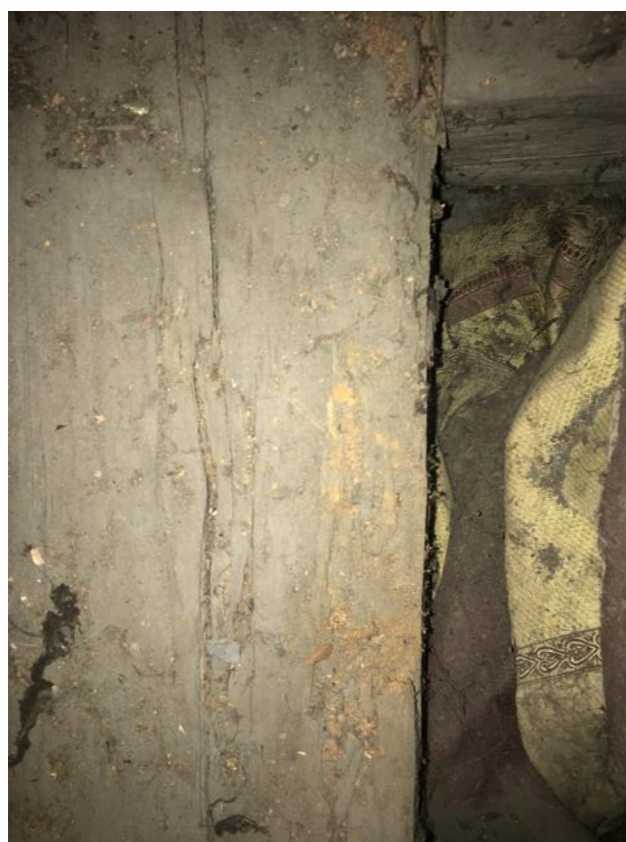
Místy trámy krovu napadeny dřevokazným hmyzem
